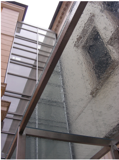
Corte interna – pensilina coperta e nuovo vano ascensore
